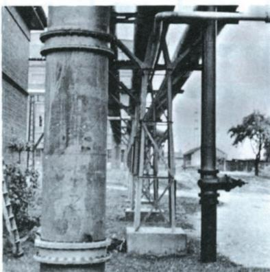
Ziefler-Rohrgelenke Bauart „RG“ sind nicht feststellbar. Sie gehören zu den beweglichen Rohrverbindungen, nehmen während des Betriebes Längenänderungen auf und lassen radiale Bewegungen (z. B. Senkungen) der beiden durch das Rohrgelenk verbundenen Rohrleitungsteile zu.
